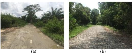
**Gambar 5.** Kondisi infrastruktur jalan di Danau Sebedang (a) Perkerasan Tanah, (b) Perkerasan batu (Hasil Observasi, 2019)
